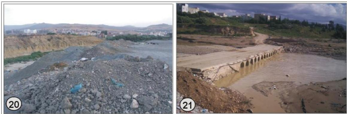
**Photos 20 et 21** montrent l'effondrement des ponts au moment où augmente le débit des eaux pluviales (banlieue de Taza).
